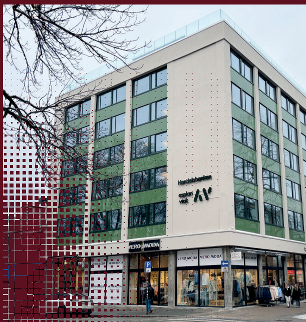
Veidekke Bygg Trondheim
